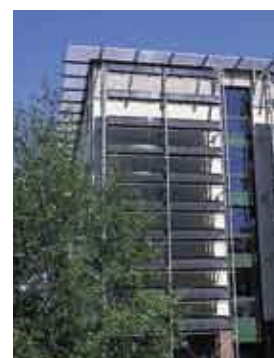
Fig. B.1.6-17 Montaggio sulla facciata, superfici inclinate
