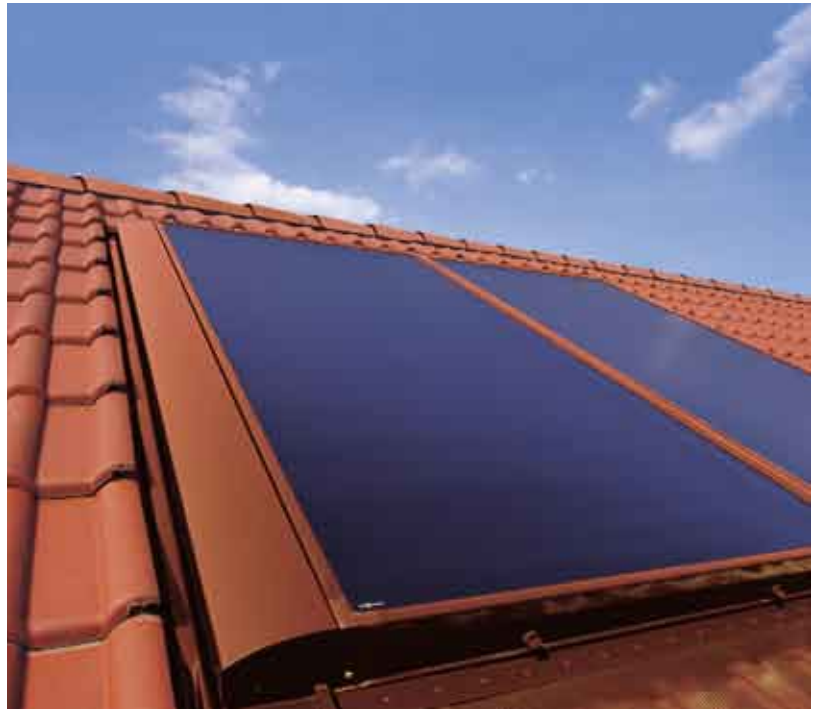
Fig. B.1.7—3 Il collettore come elemento del tetto dai colori abbinati.
