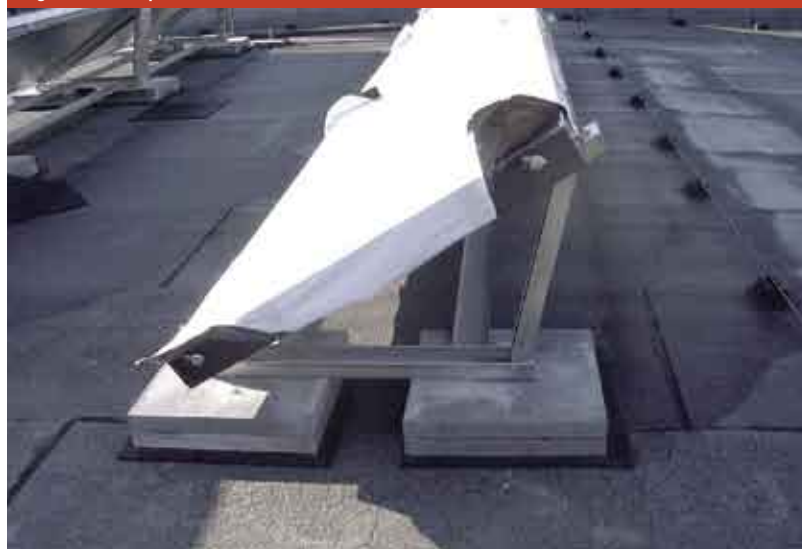
Fig. E.1.2-1 Copertura collettore
