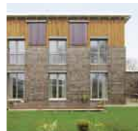
Fig. B.1.6-14 Montaggio sulla facciata, superfici verticali
