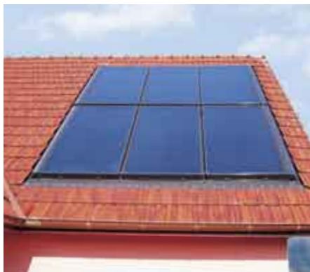
Fig. B.1.6-8 Integrazione nel tetto
