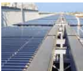
Fig. B.1.6 -12 Montaggio su tetto piano (orizzontale)
